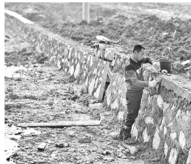
1月6日，在湘潭市雨湖区鹤岭镇双丰村，工人正在进行高标准农田建设施工。
