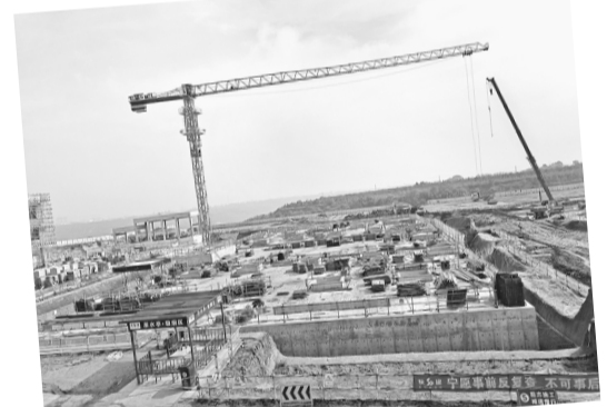
新材料产业园污水处理厂项目建设现场
