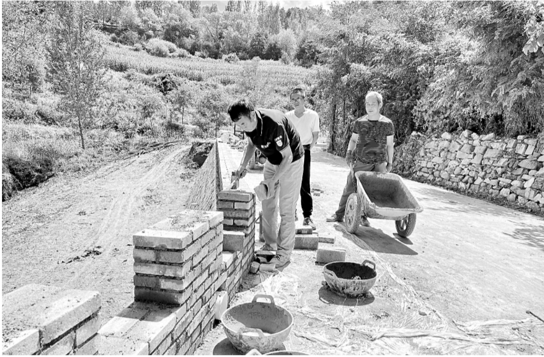
金锁关镇背塔村范家塔通组道路施工现场
