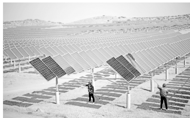
3月25日，工作人员在银川市第四光伏电站对光伏板进行除尘作业。宁夏银川近日迎来大风沙尘天气。沙尘过后，为确保沙漠光伏发电项目安全、稳定运行，国网银川供电公司联合辖区光伏电站，开展排查线路及变压器安全隐患、清洁光伏面板等工作，对沙漠光伏项目进行春季“体检”。 新华社记者 王鹏摄
