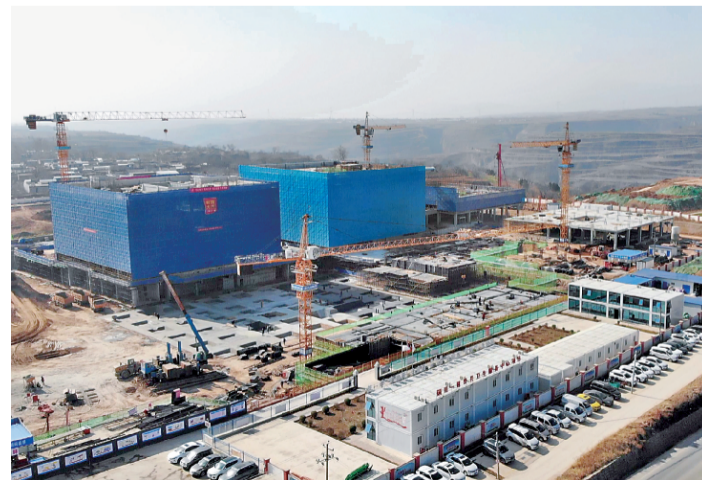
铜川市公共卫生服务中心(渭北传染病防治医院)项目建设现场
