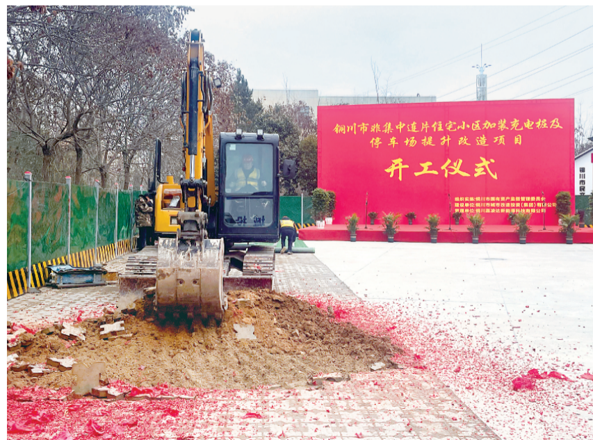
图为项目施工现场
