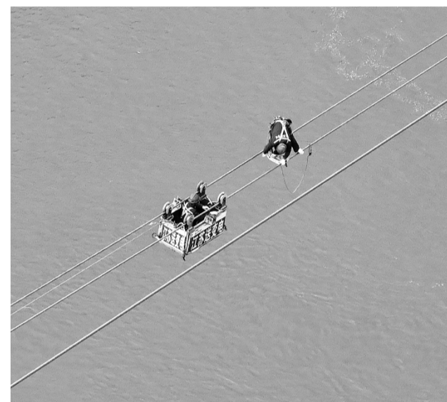
9月26日，在江苏镇江，国网江苏电力员工进行导线更换作业(无人机照片)。
